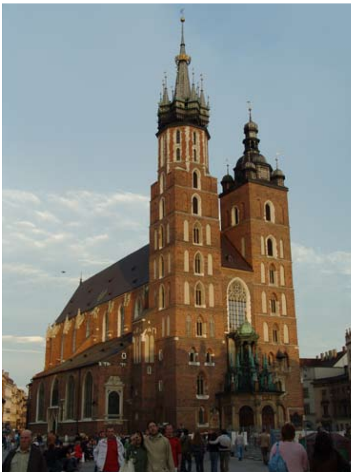
Widok Kościoła Mariackiego od strony zachodniej
